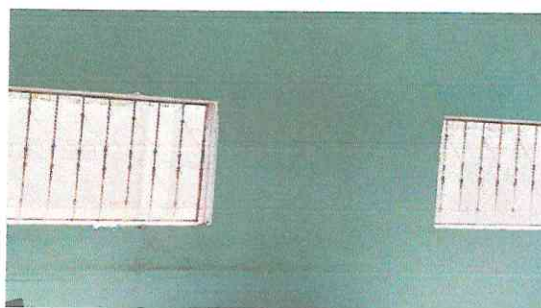
Foto 6: sustitución de ventanas de metal por PVC
