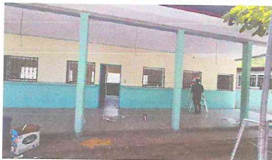
Foto 3: Sustitucion de pintura interior y exterior 3 aulas y corredor
