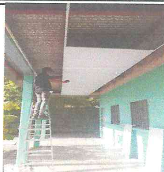
Foto 2: Sustitucion de cielo falso en mal estado en el corredor
