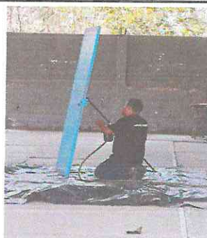
Foto 4: sustitucion de pintura de puerta salon tres
