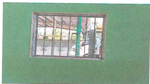
Foto 5: sustitucion de ventanas de metal por PVC
