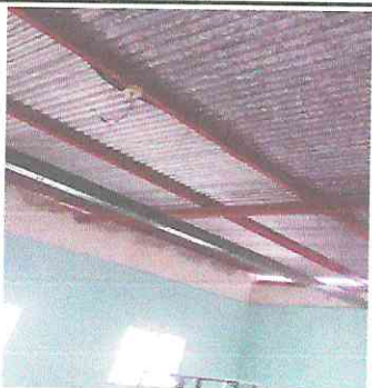
Foto1: Sustitucion de cielo falso en mal estado aula 3.
